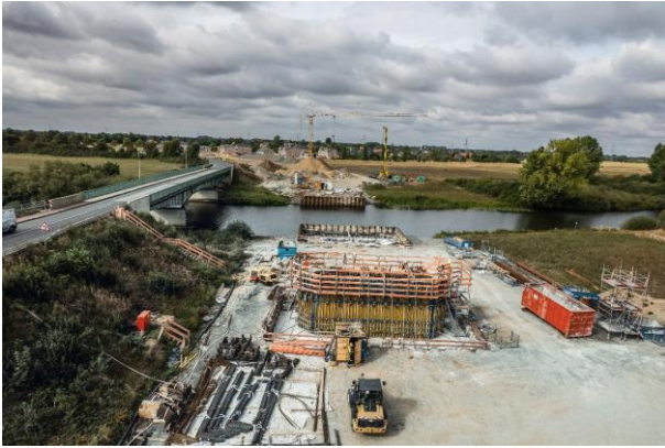
(3) Für die Brückenpfeiler wurden Bohrfahlgründungen hergestellt.
