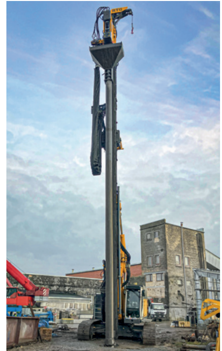
RG mit VIPAC Rohr 305 mm (RSV) RG with VIPAC casing 305 mm (VR)
