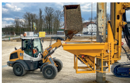
BF 15 mit TR 17 K (RSV) (Einbaumaterial auffüllen) BF 15 with TR 17 K (VR) (Fill up with installation material)
